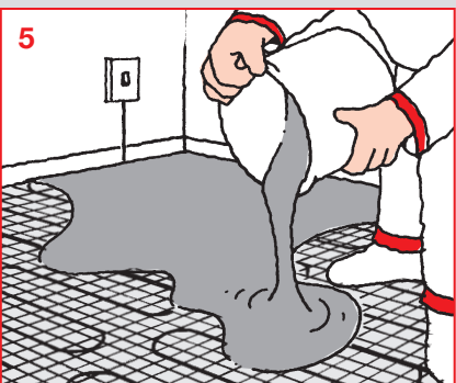
5 Observera att det måste finnas minst 5 mm tjockt skikt av x-plan över kabelns översida för el-kablar och för vattenburna system ska skiktet minst vara en tiondel av rörens avstånd (t.ex. c-avstånd mellan rör 200 mm = 20 mm x-plan över rörens översida). Finjustering kan göras när spacklet kan beträddas med försiktighet (efter 60 – 90 minuter).
